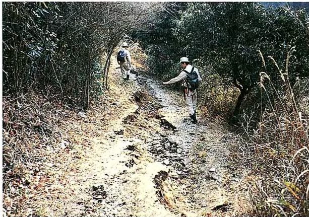
写真2 亀裂の入った登山路 (神戸市東灘区住吉道)
