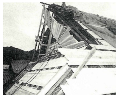
Photo. 1 茅葺から鋼板屋根への改築 (『三田市史』第9巻民俗編) より
