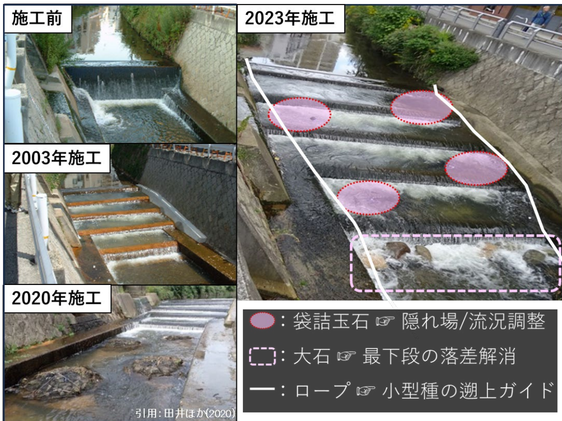
図3 津門川に設けられた階段式魚道の整備状況の変遷
