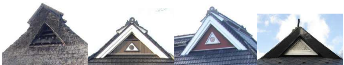
Photo. 5 西摂津（旧有馬郡）地域（兵庫県神戸市北区唐櫃地区）の事例：左/市登録溝田家住宅
