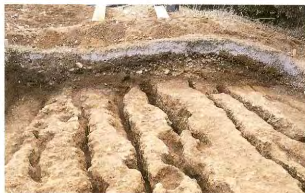
図6-7 川西市加茂遺跡でみられた伏見地震(1596年、M7.5)の地割れ跡（岡部慶隆氏提供）
