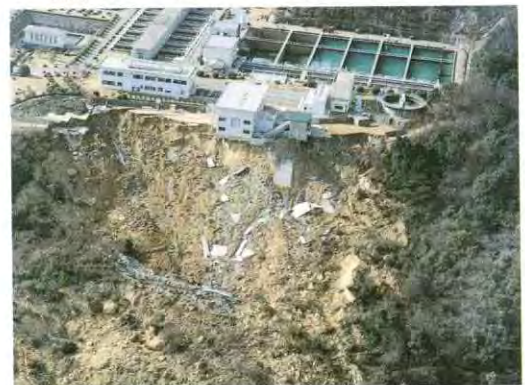
図1-10 大規模な斜面崩壊(西宮市仁川; 株式会社パスコ提供)
