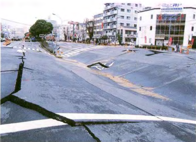
U字型に陥没した道路（神戸市兵庫区大開通）
