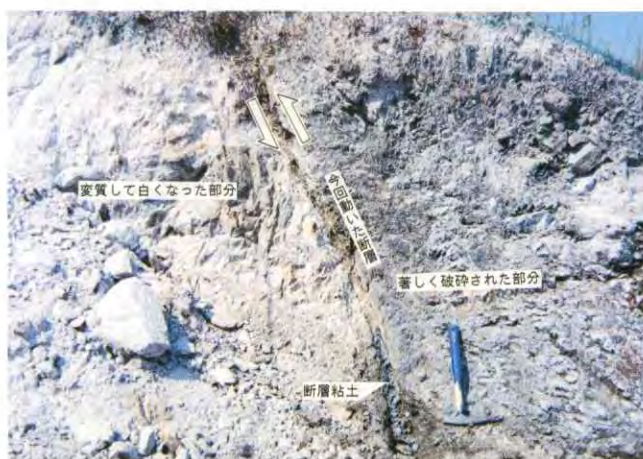
図3-2 露頭に現われた断層破碎帯(東浦町・楠本断層)
