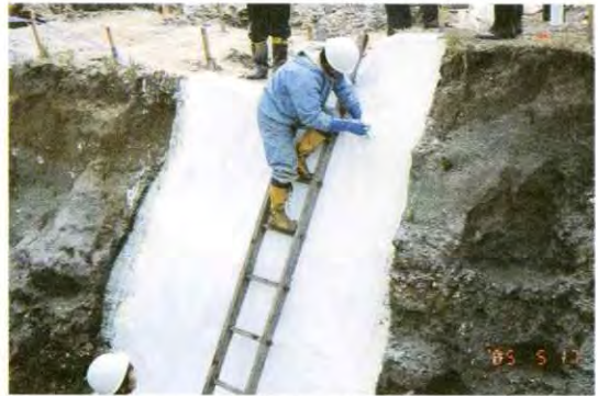
5: 壁面に補強用の布を張り付け、水で溶いた樹脂を塗り込む。
