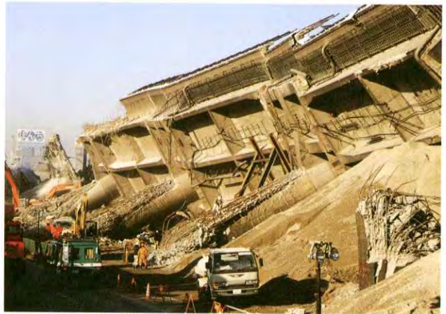
横倒しになった阪神高速道路（神戸市東灘区）
