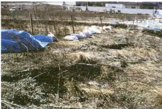
2:逆ミの字型の亀裂群（小倉地区）
